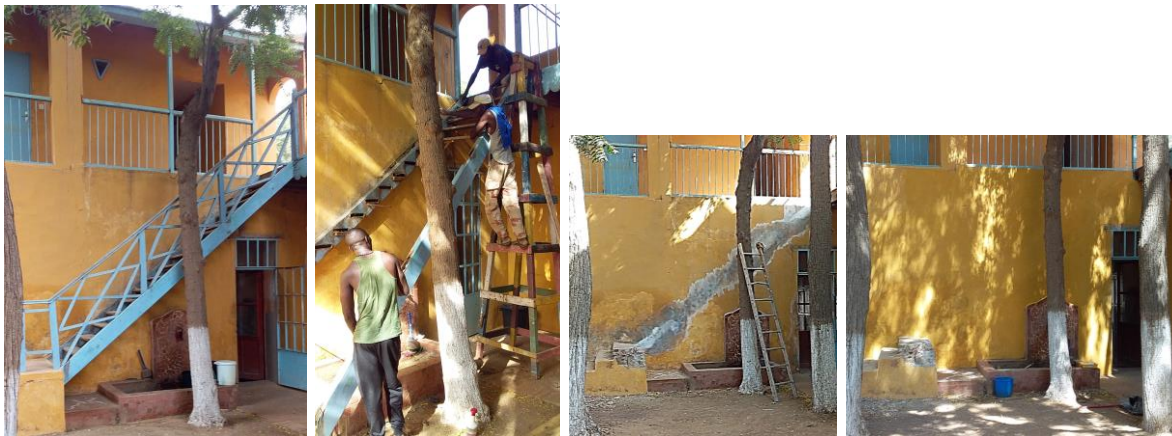
Il semble bien mais est pourri ! On le démonte Le mur est abimé, il faut le réparer avant de poser le nouvel escalier
