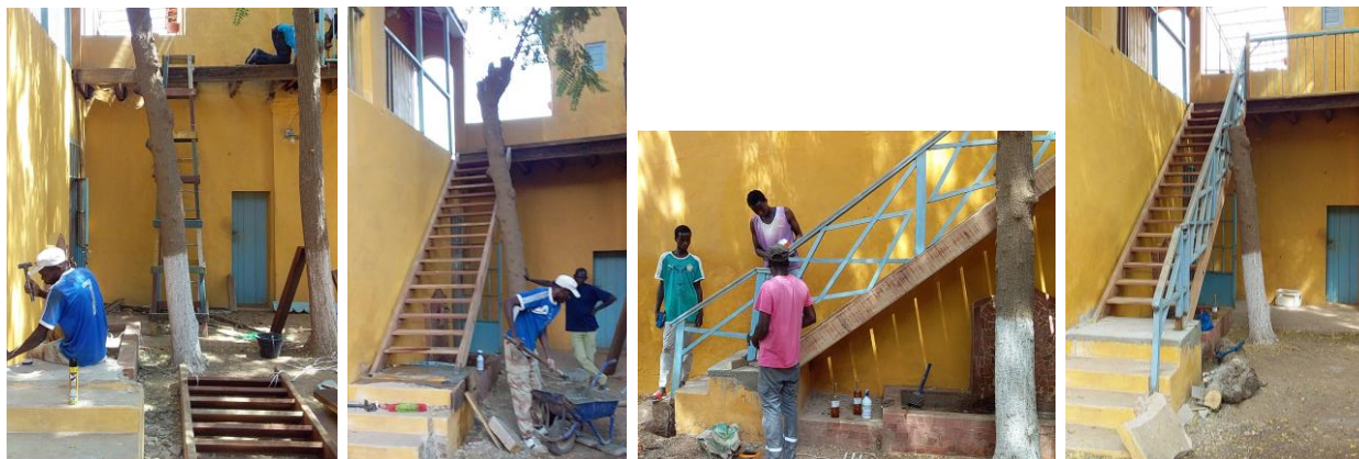
Le nouvel escalier est assemblé puis posé la balustrade en cours de pose et voilà le travail
